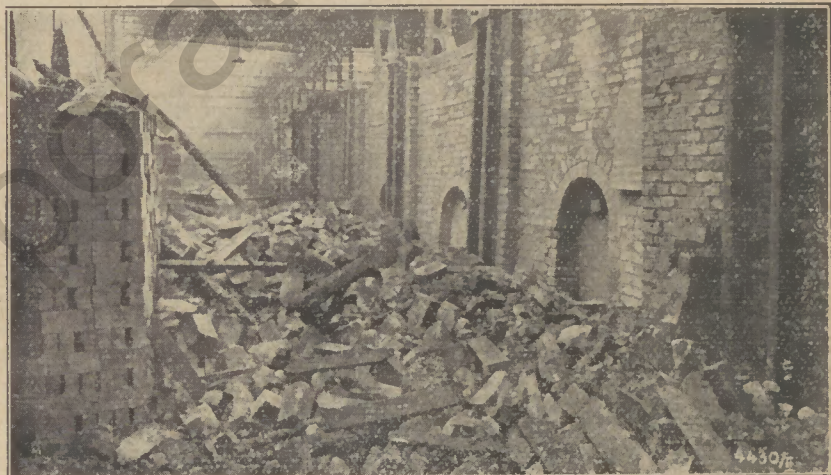
Abb. 3. Blick in die zerstörte Steinfabrik
