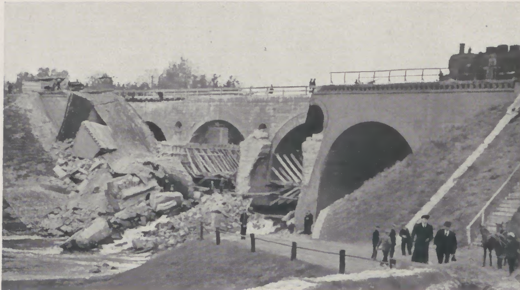
Die Brahe-Brücke eingleisig wieder befahrbar
