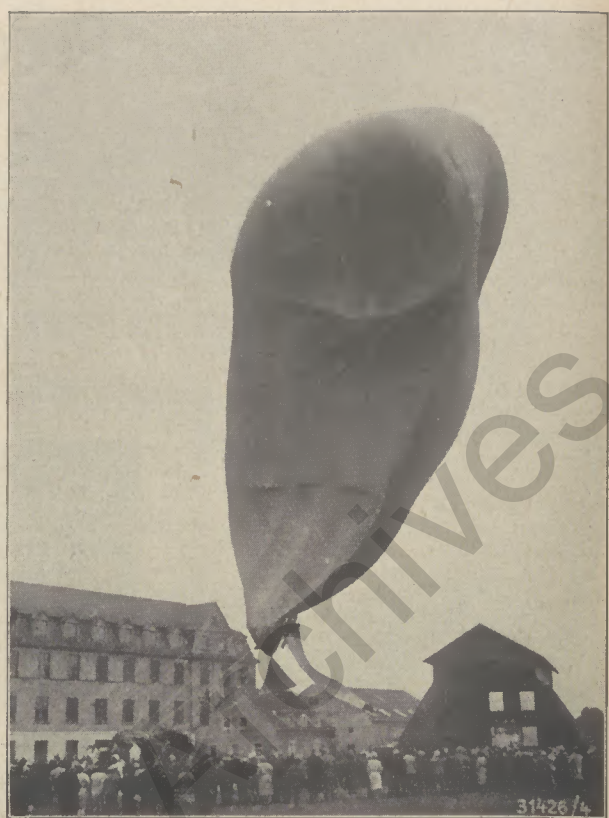
Abb. 3. Der startbereite Ballon Piccards am 14. September 1930 im Bodentwind; deutlich sichtbar die Gurte und der zugebundene Pöschelansatz
