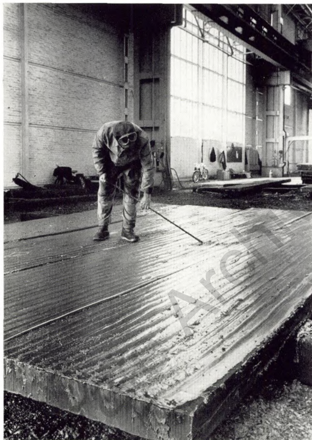
Die Vorbrammen, die für die Produktion von Breitband auf der Warm-Breitbandstraße der ATH benötigt werden, haben nach dem „Flämmen“ eine blanke, saubere und fehlerfreie Oberfläche und geben einwandfreie Bleche.
