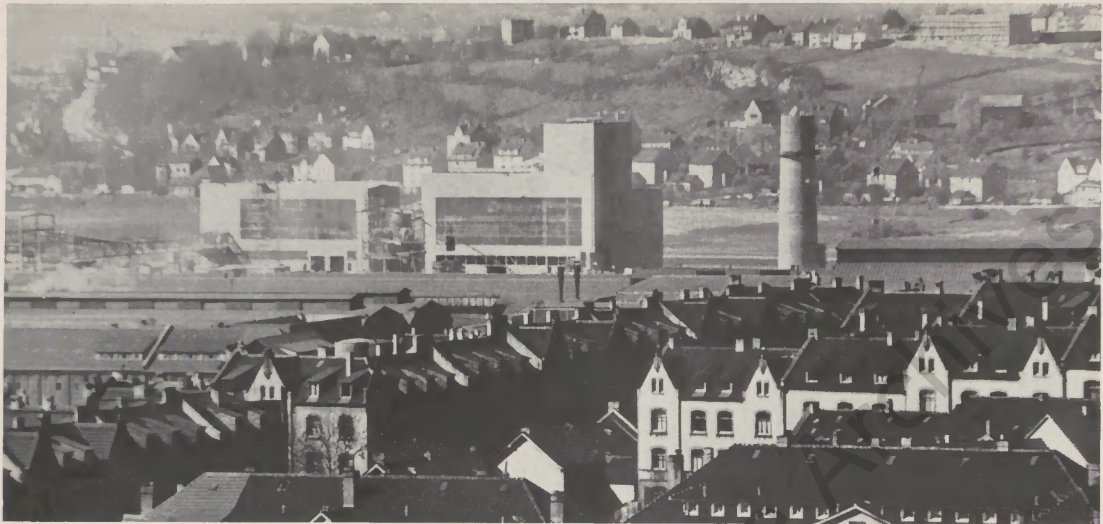
Henrichshütte: Sinteranlage und 140-m-Kamin im Bau
