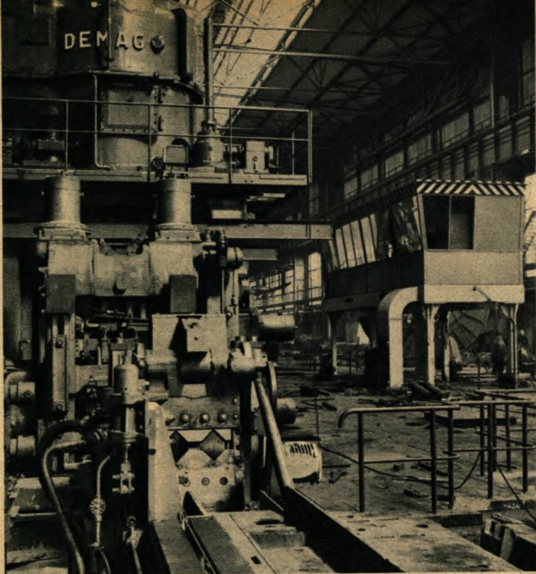
Nach Verlassen der Walzstaffel II werden die Stäbe von einer „fliegenden Schere“ zerschnitten. Diese fliegende Schere, die mit Prelluft betrieben wird, teilt die Stäbe während des Durchlaufens bei einer Geschwindigkeit bis zu maximal 3,5 m/sec.
