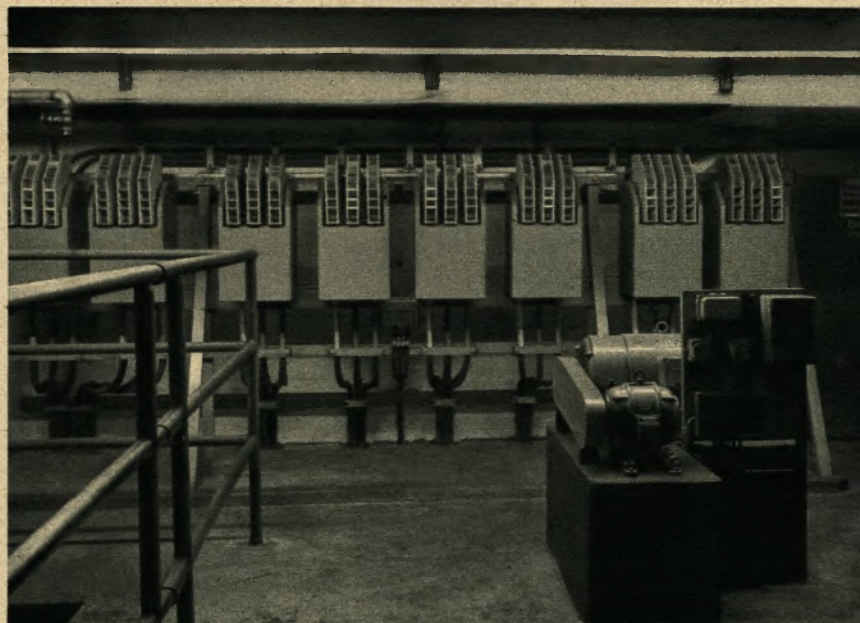
Steuerschütze auf der Seilscheibenbühne
