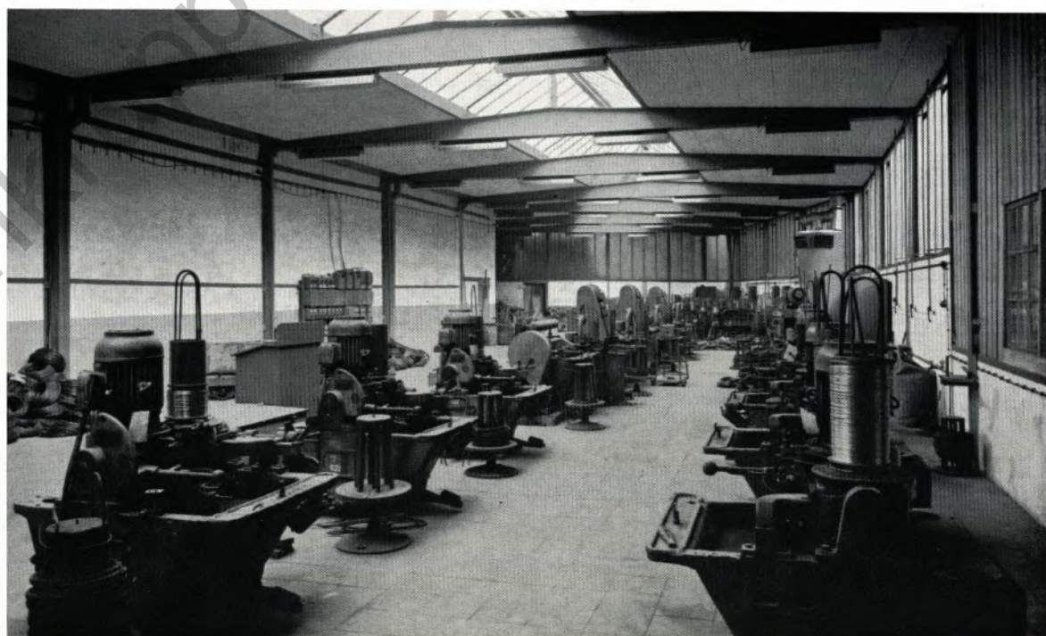
Ein weiterer Blick in die neue Halle des Drahtwerkes Altena der Westfälischen Union, die den Kratzenzug aufgenommen hat.
