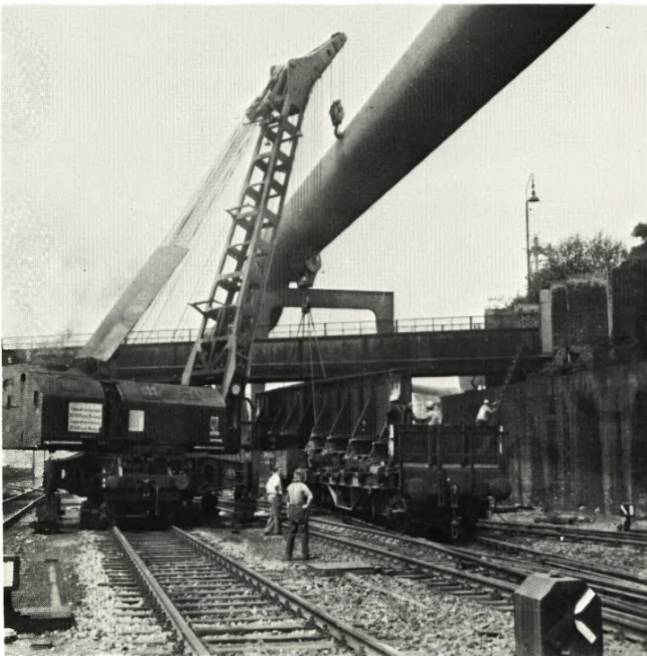
Der 90-t-Kran der Bundesbahn hat einen Teil des ersten Überbaus über die Werksgleise demontiert und auf einen Werkswagen abgesetzt.
