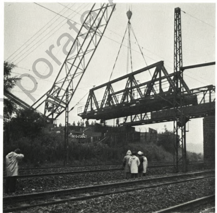
Der dritte Überbau über die Bundesbahnstrecke mußte in einer kurzen Betriebspause mit einem 500-t-Autokran abgehoben werden.
