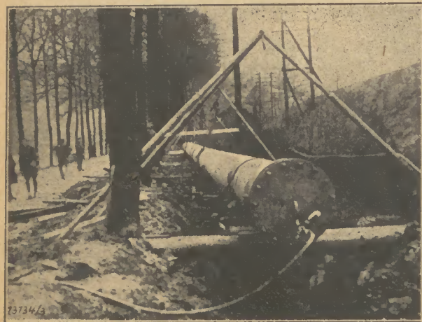
Die Dichtigkeitsprüfung der Rohre
