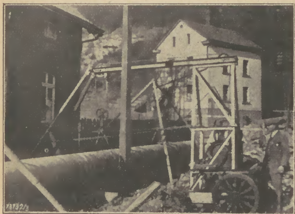
Spezialkran zum Versenken der Rohrstränge
