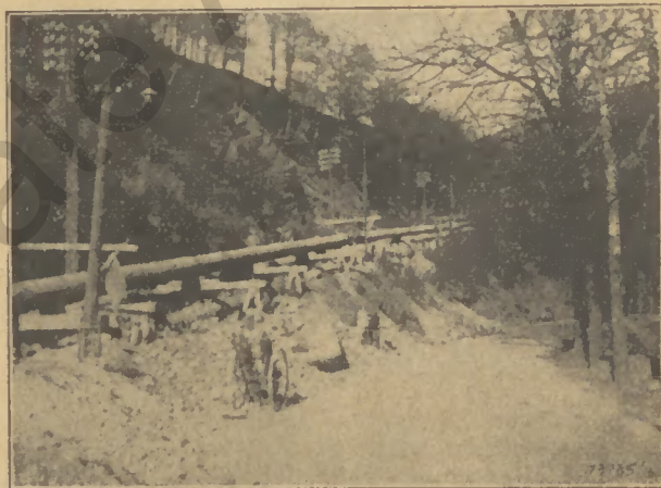
Der Rohrleitungsstrang kurz vor dem Versenken
