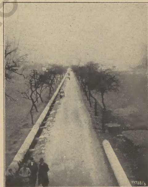
Der kilometerlange Rohrleitungsstrang
