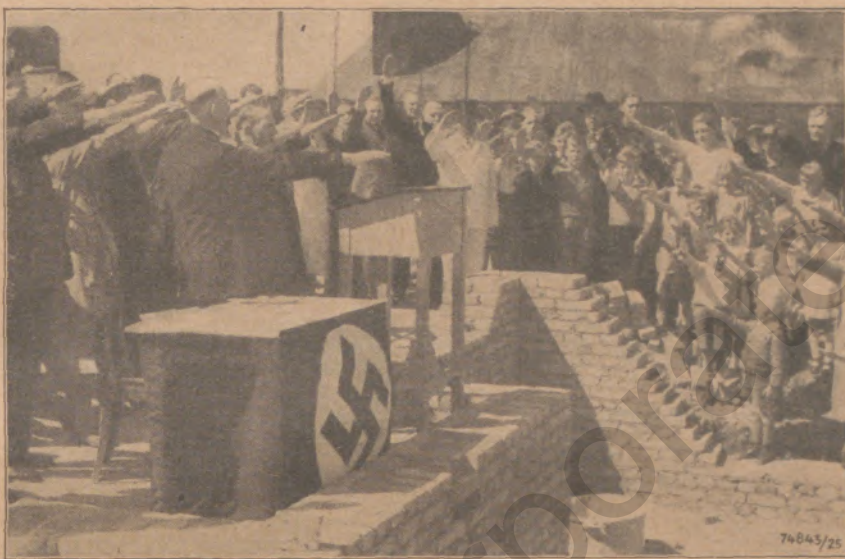
Am 17. Mai 1936 wurde der Grundstein zur Siedlung in Hacheney gelegt
