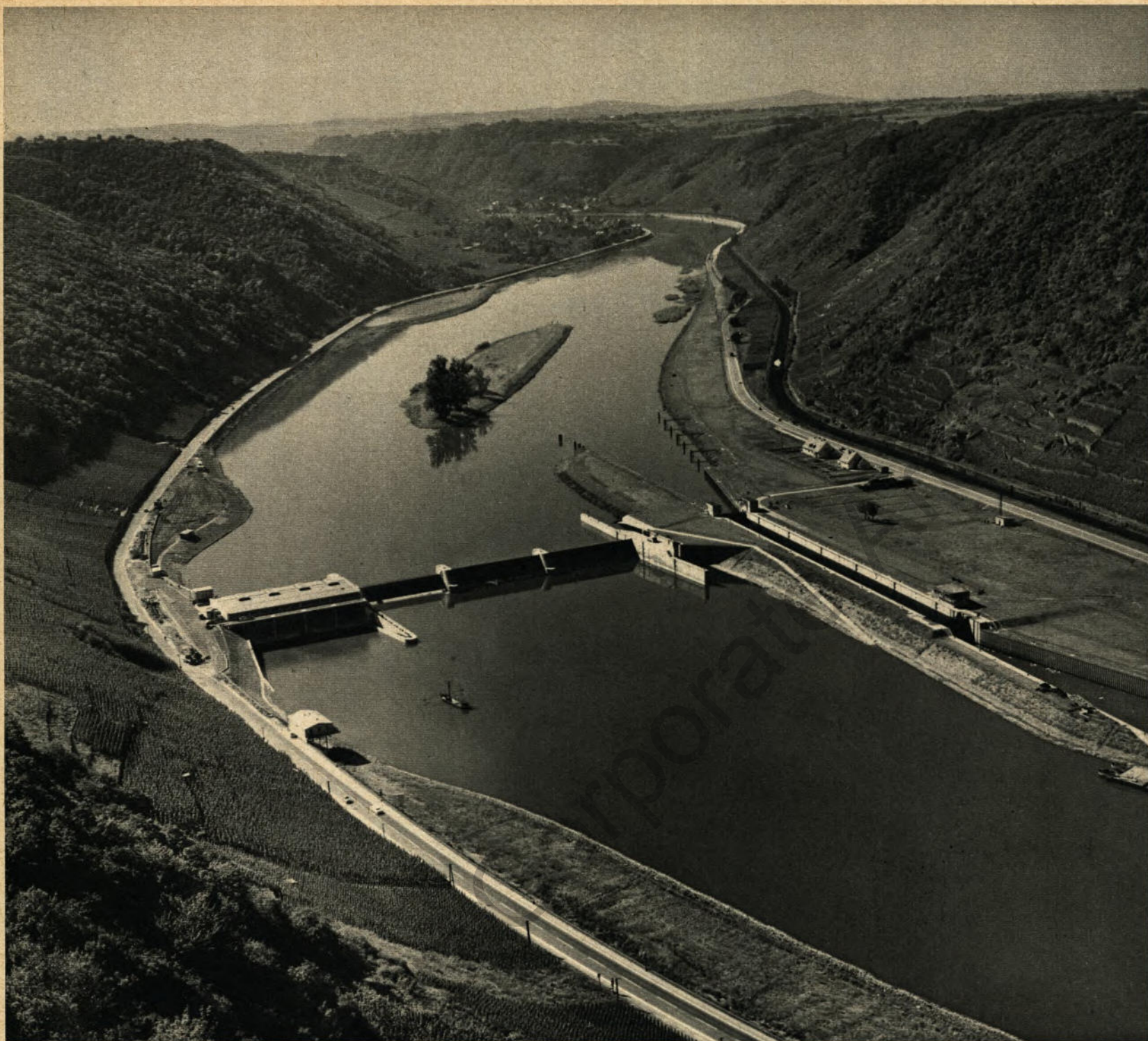
▲ Hier ein Blick auf eine der Staustufen (Lehmen), die alle den Zweck haben, ruhiges und tiefes Fahrwasser für den Schiffsverkehr zu schaffen
