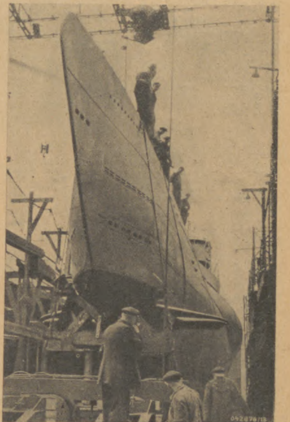
Immer noch mehr U-Boote Das letzte Kommando vor dem Stapellauf, das Wegschlagen der Bremsklötze, wird ausgeführt
