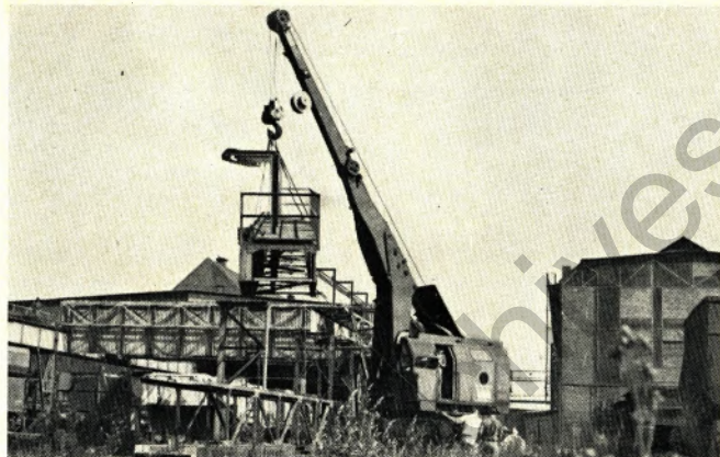
Verlängerung der Hofkranbahn um 25 m unserer Werkhalle 7 der Eisenbahnwerkstatt. Unser 25-t-Diesel-Schienenkran beim Einhängen des vorgefertigten Kranbahnträgers.
