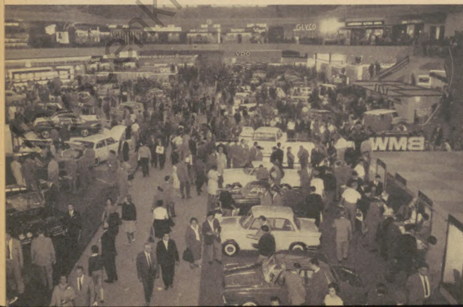
Blick in die Halle 1a
