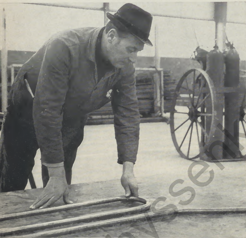
Vorarbeiter Heups, der den Verbesserungsvorschlag „Biegeringe“ einreichte, kontrolliert hier die zeichnungsgerechte Ausführung einer Rohrschlange.
