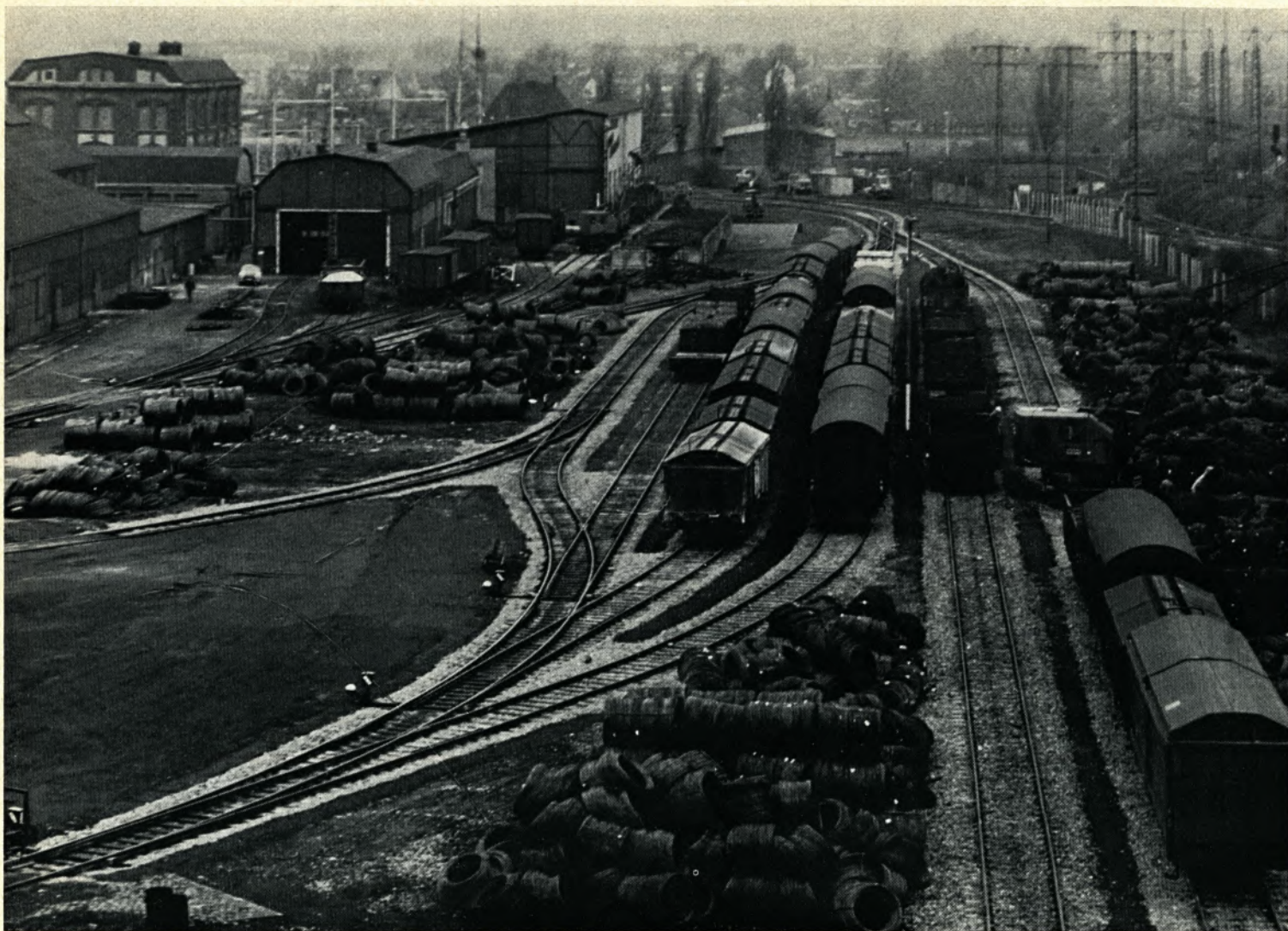
Blick auf den Werksbahnhof mit den Bogengleisen zum Blankdrahtlager und dem Lager für Schweißelektroden. Rechts im Bild zwei Stumpfgleise.
