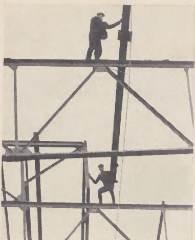
Artistische Leistungen in schwindelnder Höhe vollbringen die Männer, die eine neue Halle für unser Reisholzer Werk errichten. Auf schmalen Stahlträger balancieren sie sicher wie Fußgänger auf ebener Erde. Dabei transportieren sie sogar auch beachtliche Lasten. Lesen Sie dazu unseren Bildbericht im Inneren des Heftes.
