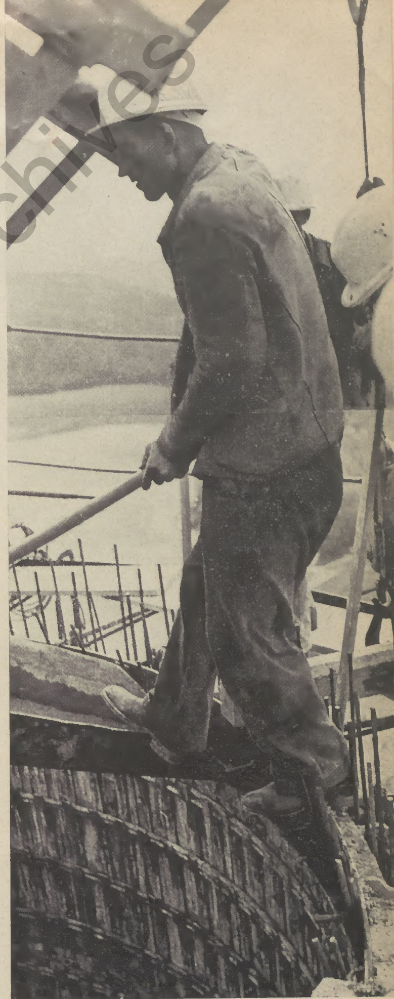
In luftiger Höhe entstand der Gerresheimer Fernsehturm. Als Baumaterial fand auch Stahl Verwendung. Foto: Thielbeer
