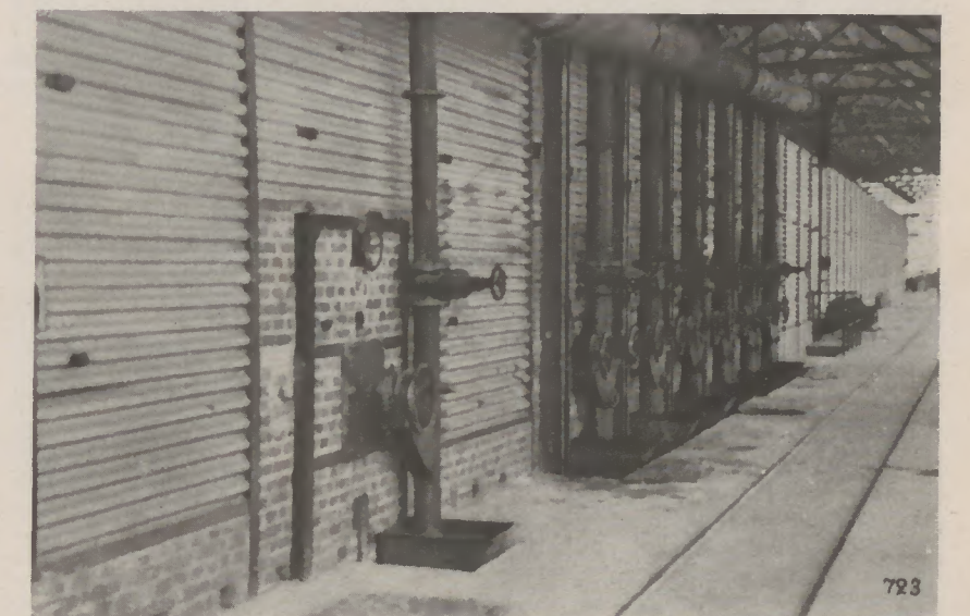
Abb. 4: Gesamtbild vom Tunnelofen mit Brenn- und Abkühlzone
