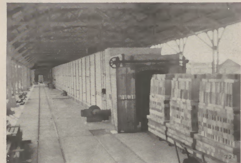
Abb. 5: Tunnelofen-Gesamtbild. Ausfahrende mit beladenen Brennwagen und Tunnelofenhalle.
