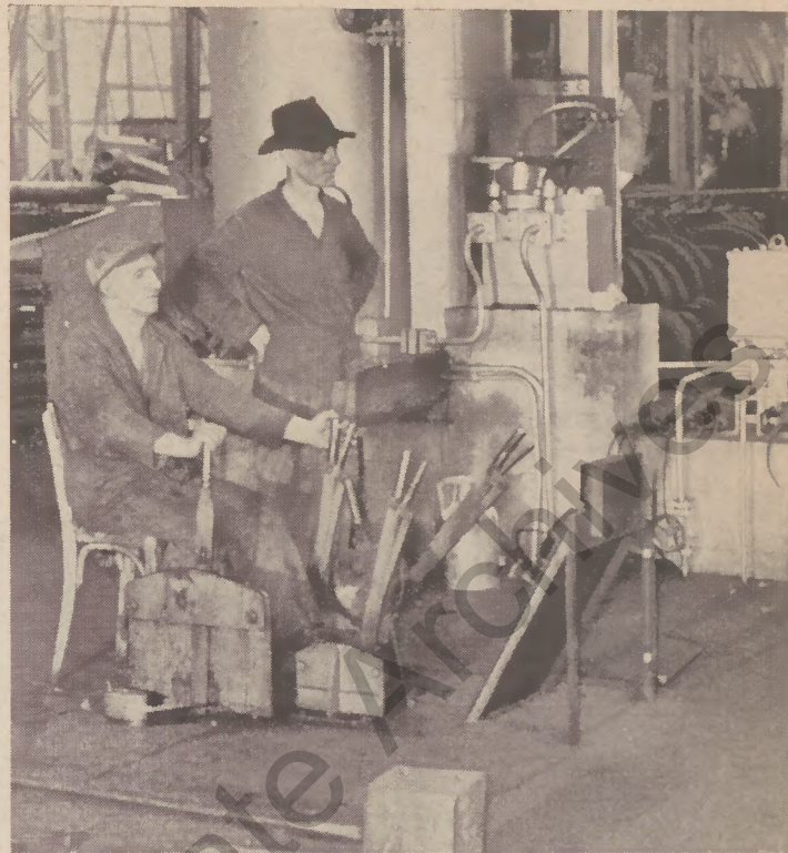
Bedienungsstand der neuen 1000-t-Pressen
