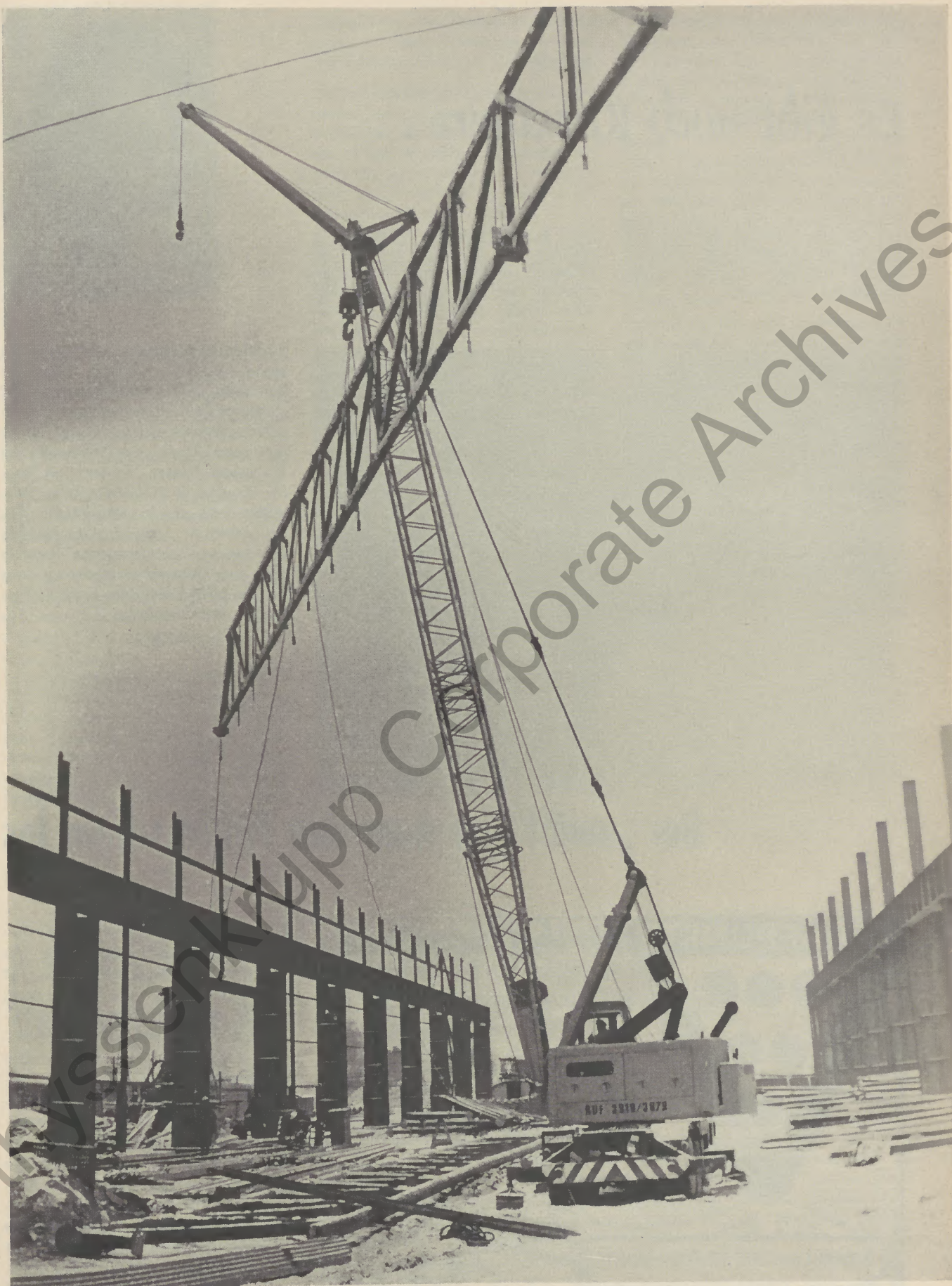
Montage einer Halle in Stahlkonstruktion unseres Werkes Langenei
