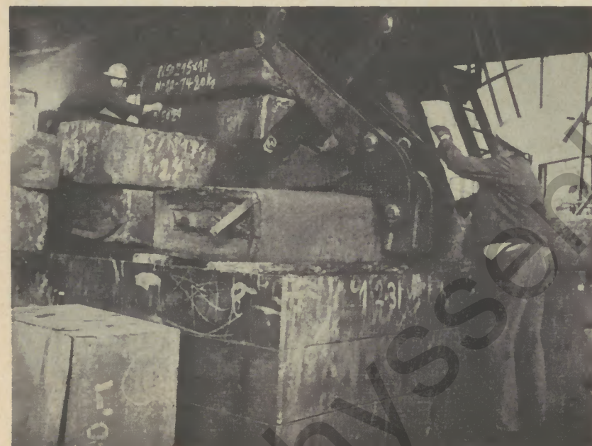
Im Vordergrund: Wiegen der Bramme. Im Hintergrund: Signieren der Brammen
