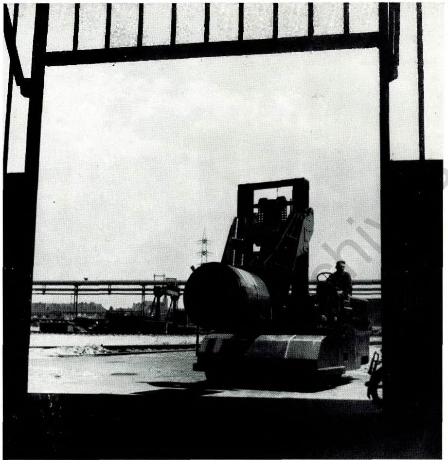
Im Kaltwalzwerk unserer Hütte sind Stapler eingesetzt, die an Stelle der Gabel einen Dorn besitzen, mit dem sie die bis zu 15 Tonnen schweren Breitband-Ringe tragen. Hier bringt ein solcher Dornstapler gerade ein Coil von der Beize zur Vierfach-Tandem-Straße
