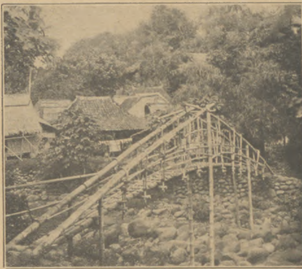
Bambusbrücke über den Tiliwong in Java.
