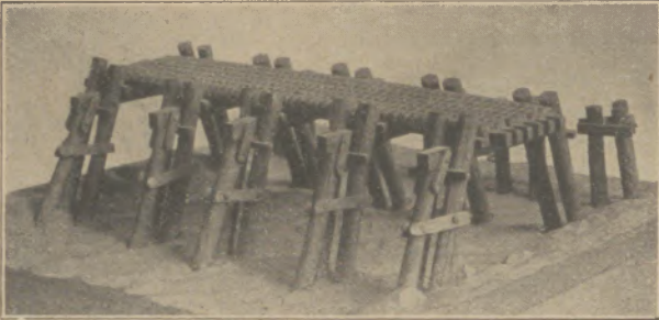
Modell der Fochbrücke des Julius Cäsar über den Rhein bei Koblenz, gebaut 55 v. Chr.
