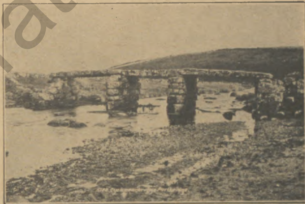
Eine der ältesten Steinbrücken in England über den Dartfluß bei dem Dorf Postbridge.
