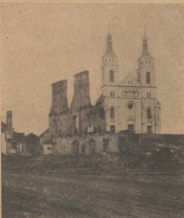
Die Kirche von Krajeow inmitten zerstörter Häuser
