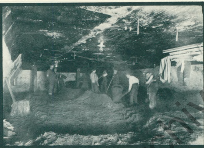
Im Caisson 16 Meter unter dem Rheinwasserspiegel. Das Bild läßt die im Text beschriebenen Arbeitsvorgänge deutlich erkennen.
