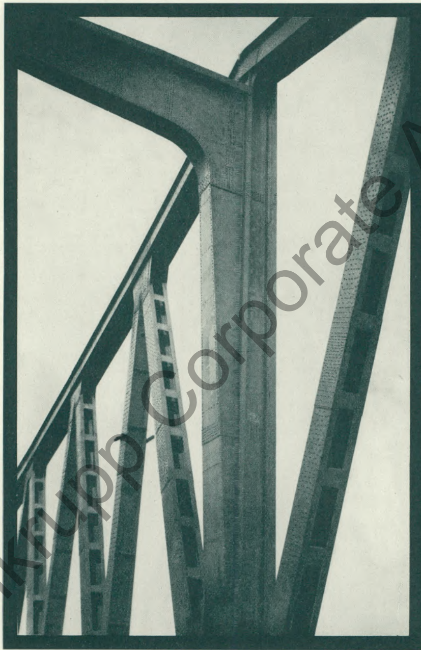
Hauptträger der neuen Düsseldorfer Rheinbrücke.
