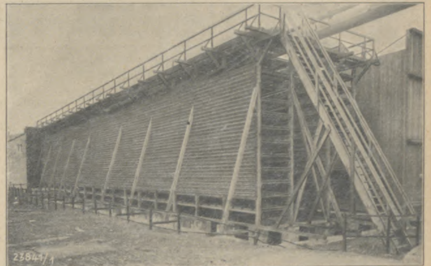
Gradierwerk einer Nebengewinnungsanlage
