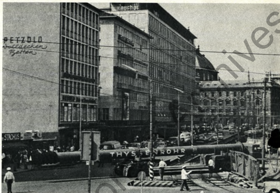
Eine der Stahlrohrstützen von 33 m Länge, 813 mm Durchmesser und einer Wanddicke von 60 mm, die bei dem Tiefbauprojekt am Karlsplatz in München verwendet wurden.
