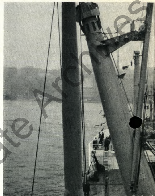
Ein Schwergutladegeschirr von 150 t Tragkraft, das unsere Tochter „Stahlform Berlin“ für das Linientransportschiff „Oranjeland“ von Blohm +
