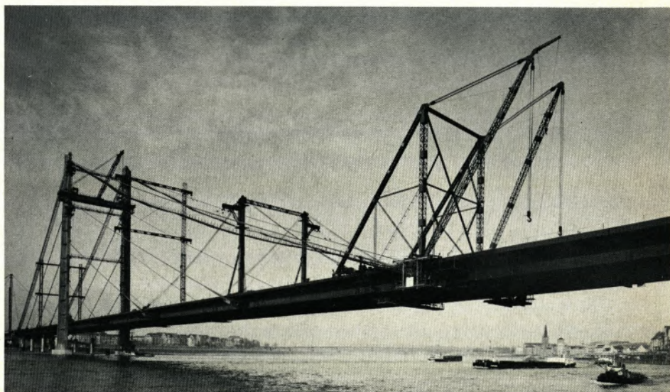
Unser Umschlagfoto zeigt die nach der Fertigstellung im Rohbau aufgenommene Kniebrücke, Düsseldorfs kühnstes Brückenbauwerk, für das wir Grobblech und Lichtmaste lieferten. 2
