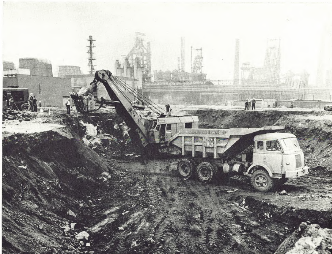
Beim Hochofenwerk Hamborn wurde der Bau eines neuen Hochofens von über 9,5 m Gestelldurchmesser begonnen
