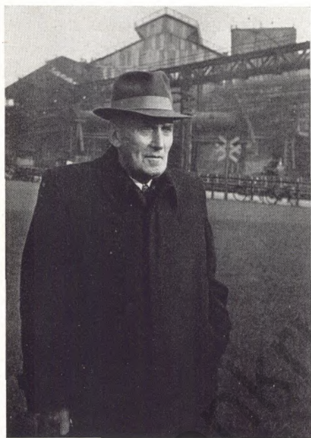
Der frühere Betriebsleiter unserer Hochofen- anlage, Werzner, sieht nach 50 Jahren nochmals seinen alten Arbeitsplatz auf der ATH
