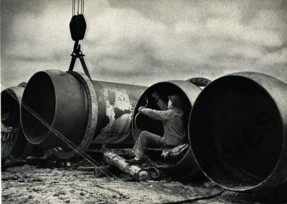
Im VRB-Werk Dortmund-Marten wurden die Kugelgelenkverbindungen für die Rohrstränge der Bodensee-Entnahmeleitungen angeschweißt. Das Gelenk ermöglicht ein Abwinkeln der Stränge bis max. 26,5 Grad
