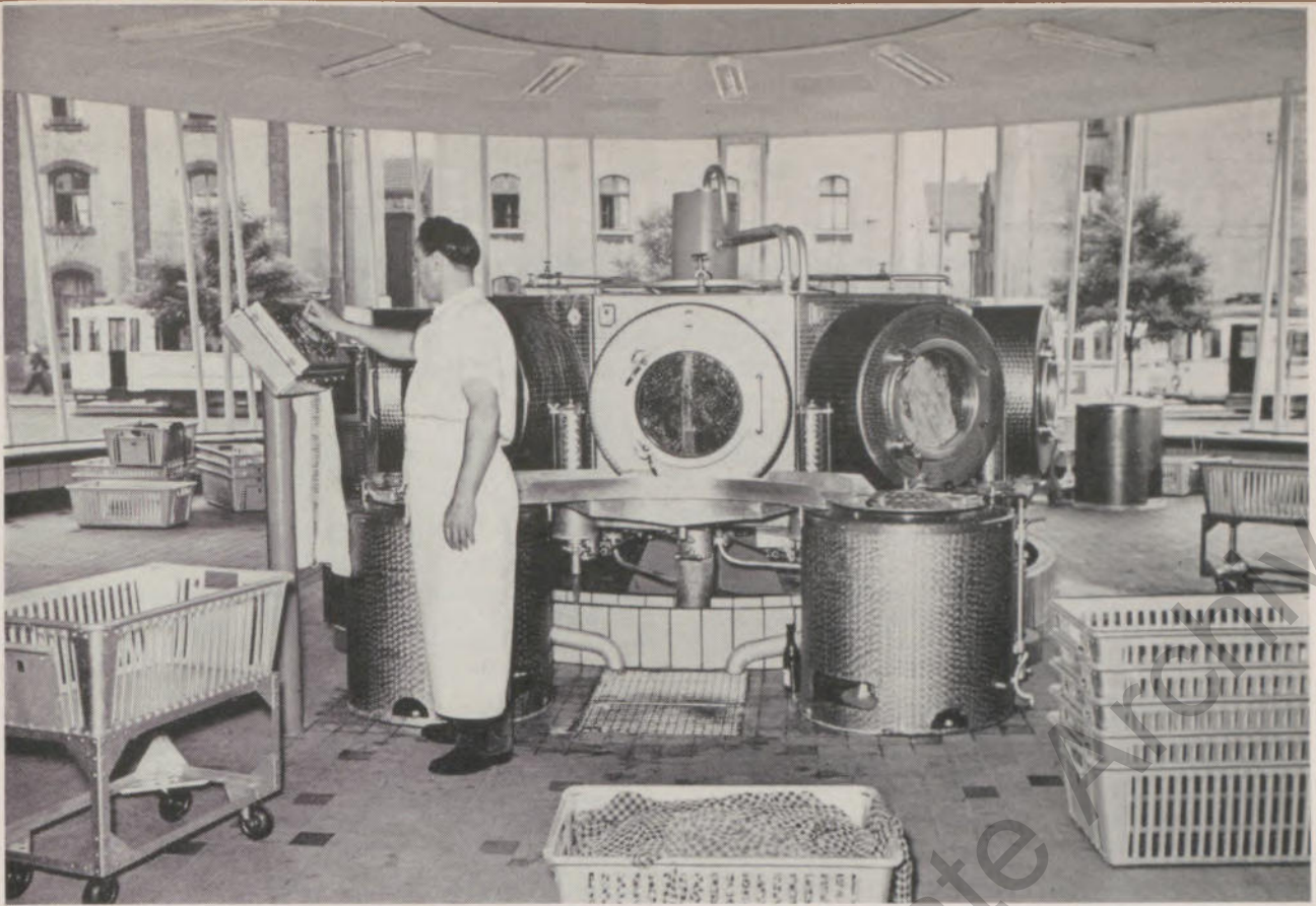
Blick auf das Waschkarussell mit den Waschmaschinen; links der „Kommandostand“, rechts im Vordergrund eine Zentrifuge
