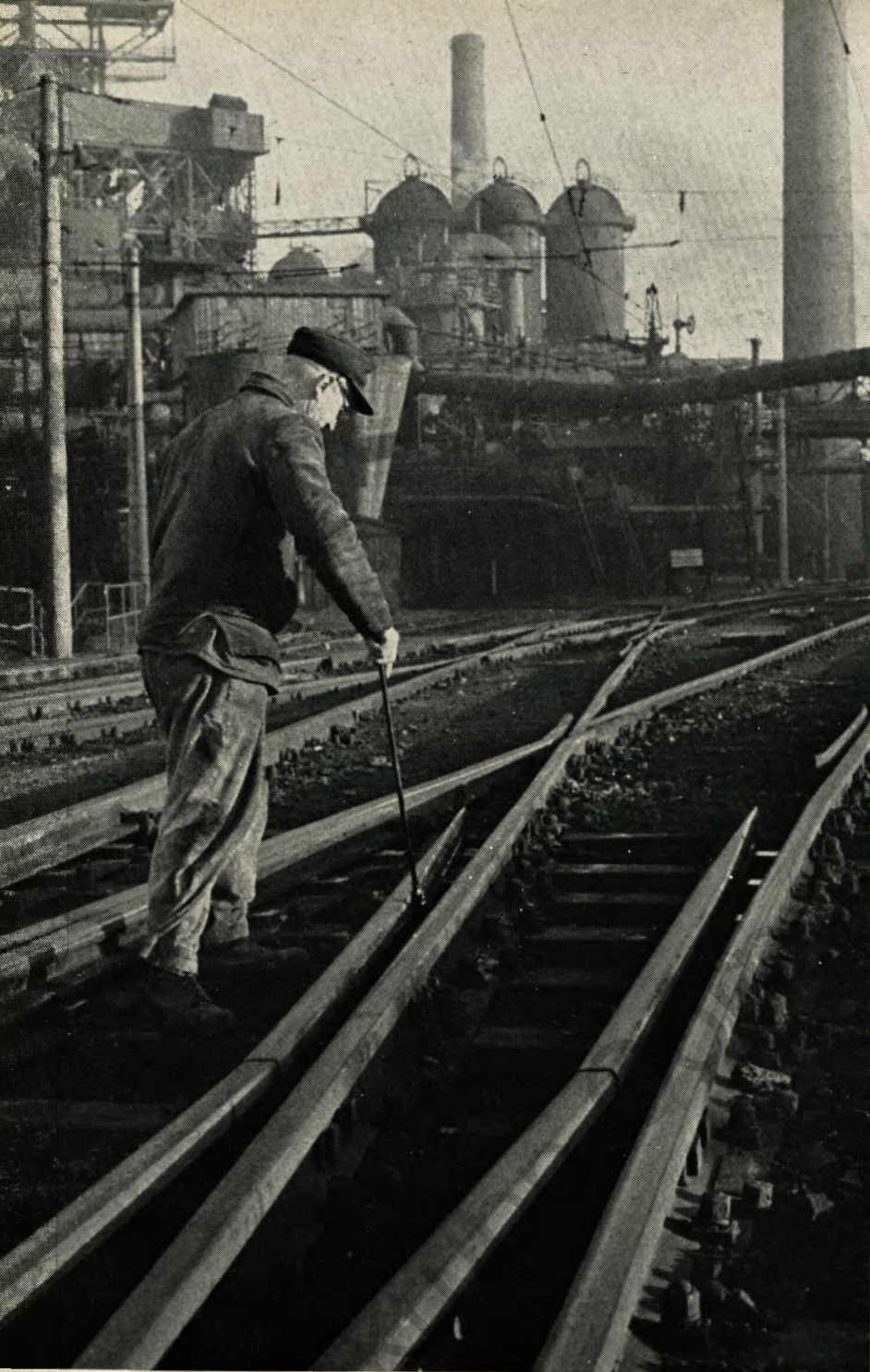
Regelmäßige Pflege der Weichen ist mit eine Voraussetzung für die Sicherheit des Eisenbahnbetriebes. Im Bilde: Streckenwärter Skrypczak beim Schmieren einer Weiche.
