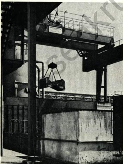
Bild 5: Mit dem Greiferkran wird von Zeit zu Zeit die Schlammflasche entleert.
