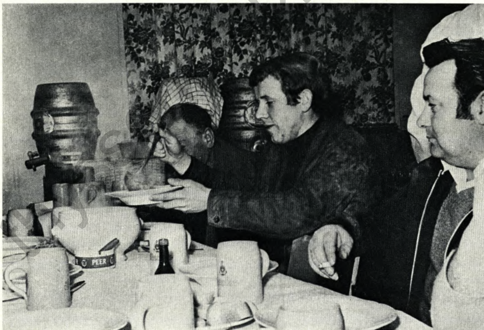
Schlag auf Schlag besten Eintopfes ließen sich die fleißigen Bauleute schmecken. Mit der Kelle können sie immer umgehen, sei sie voller Mörtel oder voller Erbsen mit Speck.
