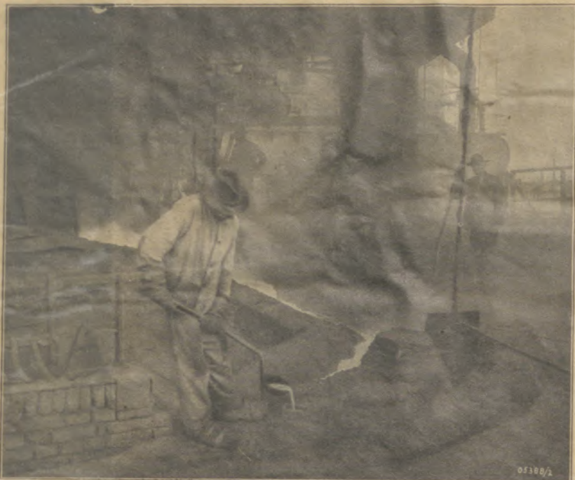
Beim Abstich — der Schmelzer nimmt eine Eisenprobe
