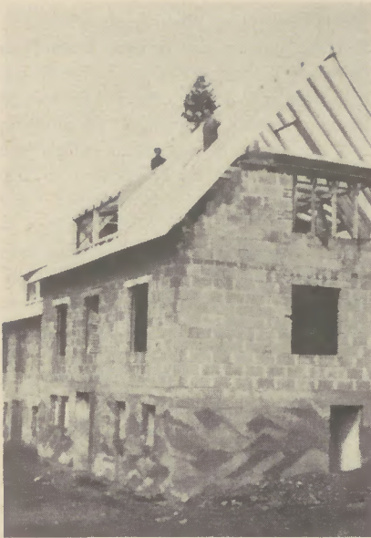
An diesem Haus der neuen Hubenfeld-Siedlung wurde der offizielle Richtakt vorgenommen.
