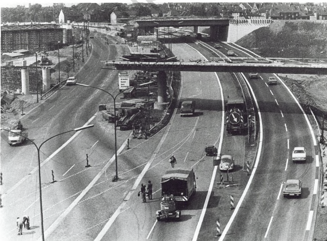
Auf diesem Bild des Knotens ist erkennbar, warum so viel Schlacke für die Dammaufschüttung notwendig war. Die August Thyssen-Hütte lieferte allein hierfür 1 Million Tonnen.
