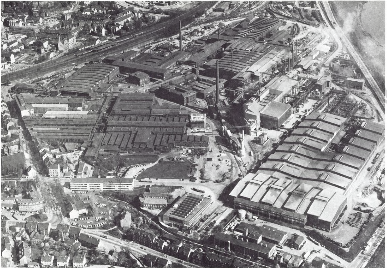
Das TEW-Werk Witten aus der Luft gesehen (Freigegeben Reg.-Präs. Darmstadt 350/74). Das Wittener Werk wurde 1854 gegründet.
