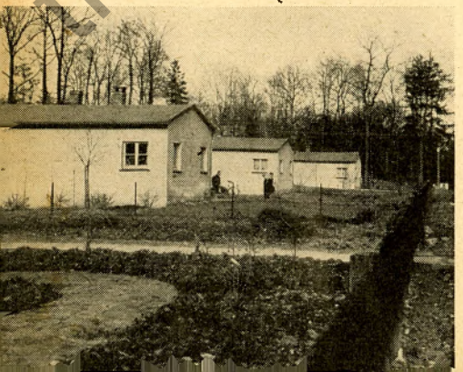
Die 38 ersten zu Wohnungen umgebauten Munahallen, die Selbsthilfe-Siedlerstellen
