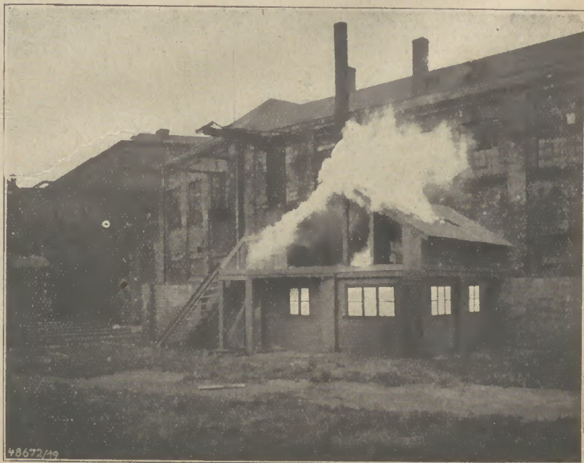
Bild 2: Entzündung einer Brandbombe auf geräumtem Dachboden
