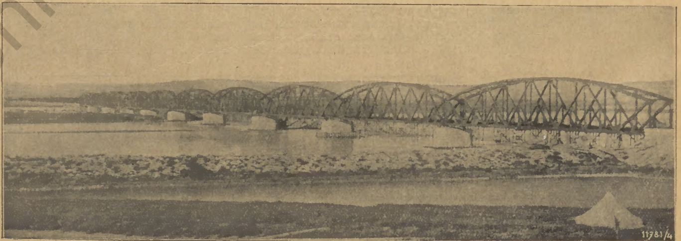
Gesamtansicht der Euphratbrücke
