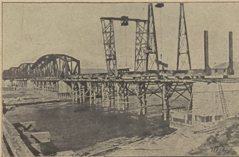
Stand der Aufstellungsarbeiten kurz vor Ausbruch des Krieges am 27. Juli 1914
