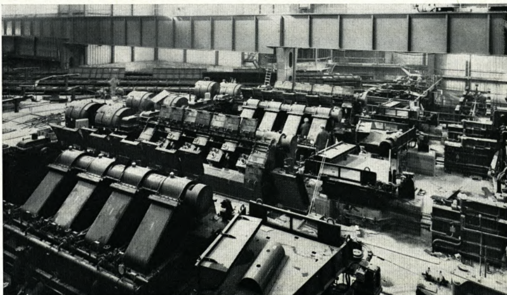
Das ist die aus 4 Fertigblöcken bestehende Fertigstraße
