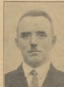
Kranführer Heinrich Kunz Maschinenbetrieb 24. November 1909
