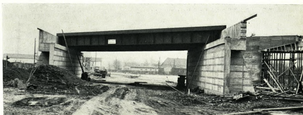
Bild 5: Gesamtansicht nach erfolgter Montage des Überbaus.
