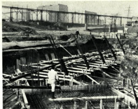
Bild 1: Nach der Ausführung der erforderlichen Erdarbeiten sind die Bewehrungsseisen für den östlichen Widerlagerfuß verlegt.
