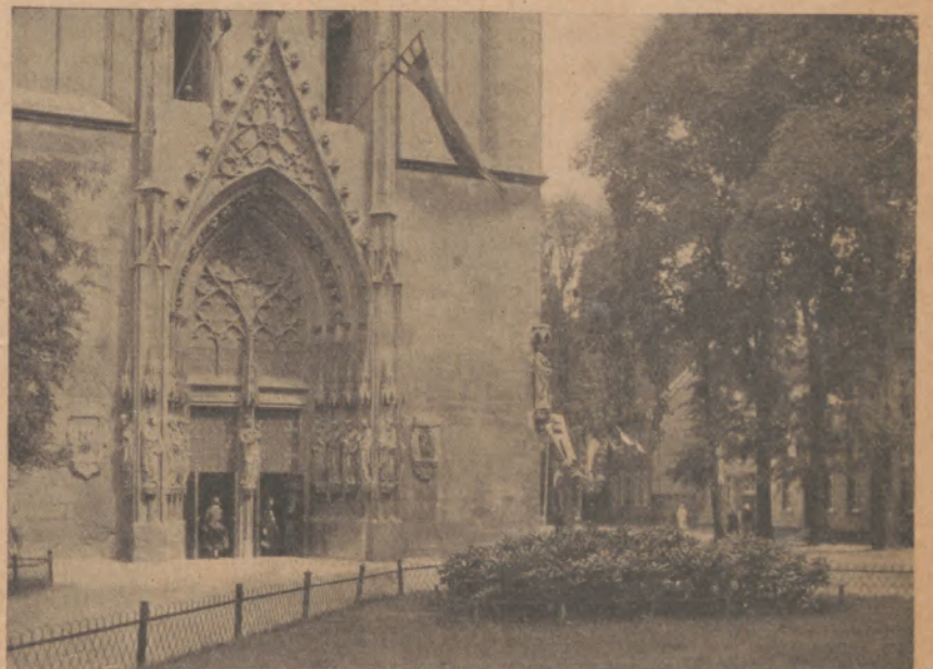
Portal der Liebfrauenkirche in Münster
