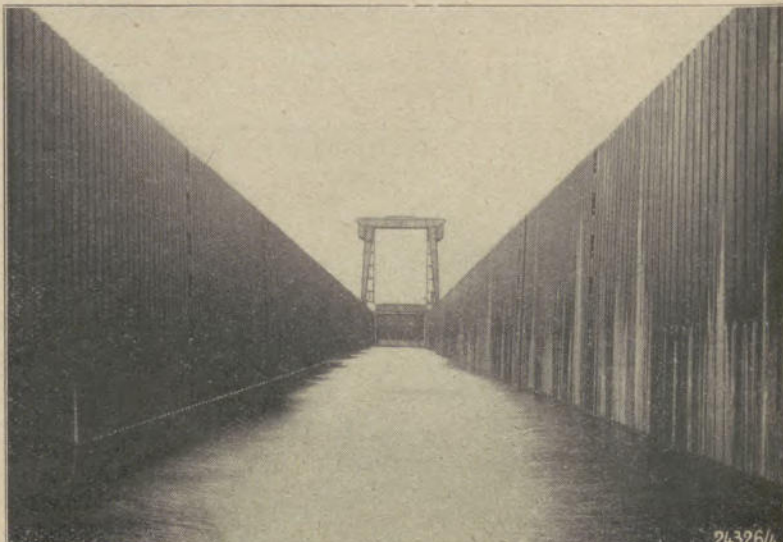
Schleuse Hänge des neuen Vipe-Seitenkanals, die größte Stahlschleuse der Erde, hergestellt aus Spundwand-eisen „Larssen“ der Dortmunder Union
