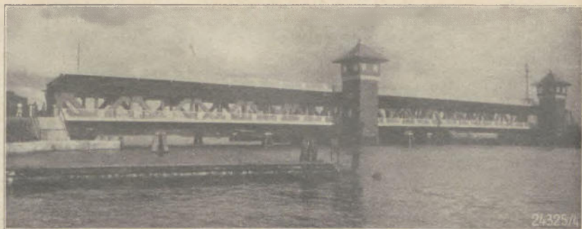
Die doppeltegetagige Pregel-Drehbrücke in Königsberg in Preußen, erbaut von der Brückenbauanstalt der Dortmunder Union
