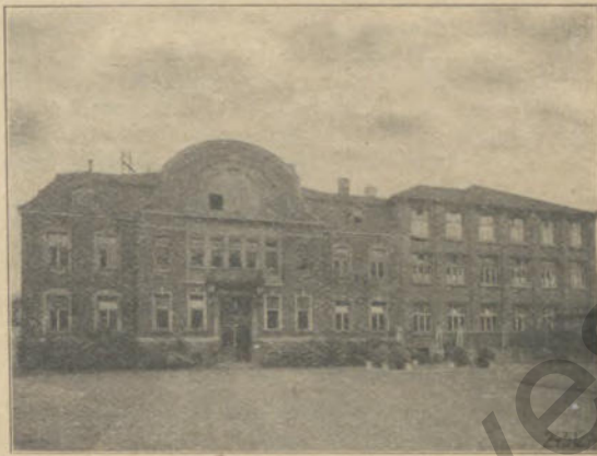
Verwaltungsbau des Schalker Vereins in Gelsenkirchen
