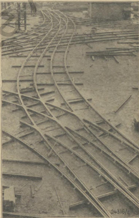
Straßenbahnkreuzungen für Rotterdam, hergestellt auf der Hütte Ruhrort-Neiderich und beim Bochumer Verein
