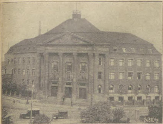
Verwaltungsbau der Hütte Ruhrort-Neiderich in Duisburg-Neiderich
