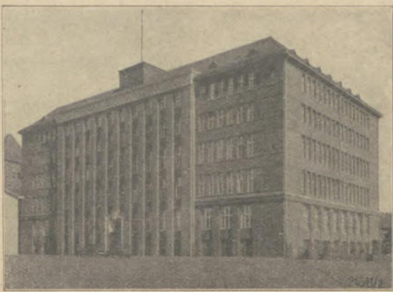
Verwaltungsbau in Mülheim-Ruhr
