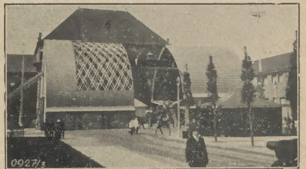
Das „Mantennetzwerk“ des Stahl-Gutshofes
