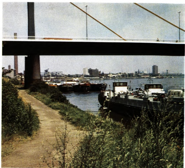
An der Homberger Autobahnbrücke.
