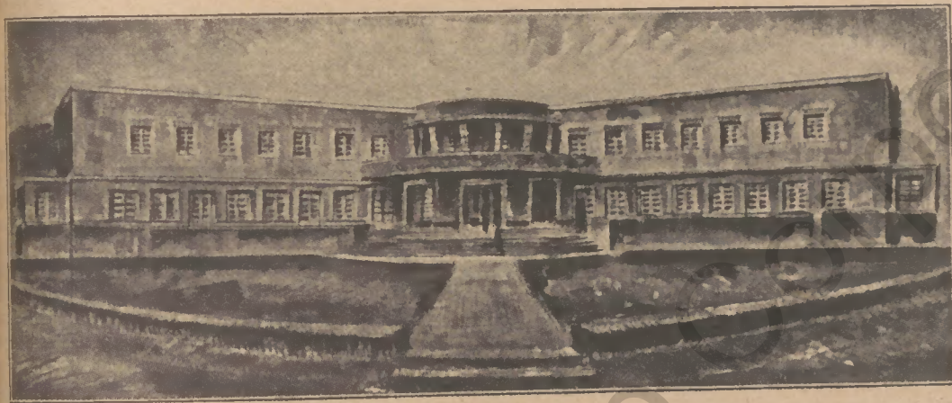
Verwaltungs- und Wirtschaftsgebäude des Flughafens Dortmund. — Front zum Flugplatz.
