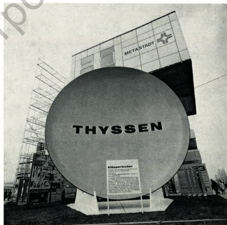
Ein Klöpperboden aus dem neuen TN-Preßwerk auf der Han- nover-Messe.
