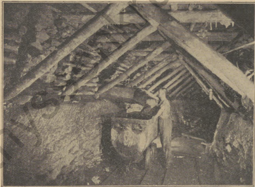
Füllstelle unter einer Schüttelrutsche.
