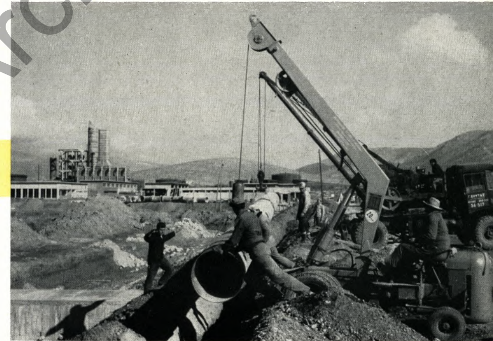
Verlegung der Kühlwasserleitung, die zur Versorgung einer mittleren Großstadt ausreichen würde
