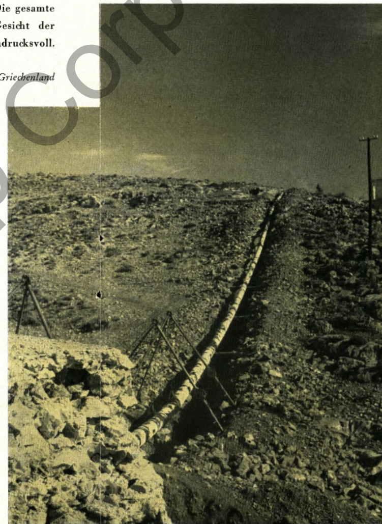
Bau der Fernleitung, die eine Länge von 24 Kilometer hat, durch felsiges Gelände
