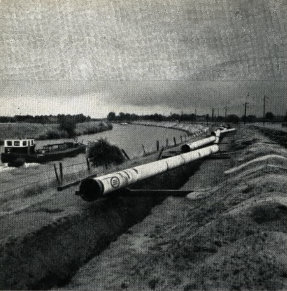
In langen Windungen folgt die noch nicht in den Graben abgesenkte Leitung dem Lippe-Seiten-Kanal
